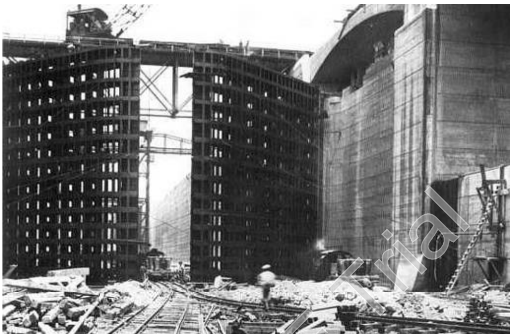
شکل ۱۰-۳. مراحل ساخت یکی از دریچه‌های قفل کشتیرانی در حال احداث (۱۹۱۳)
